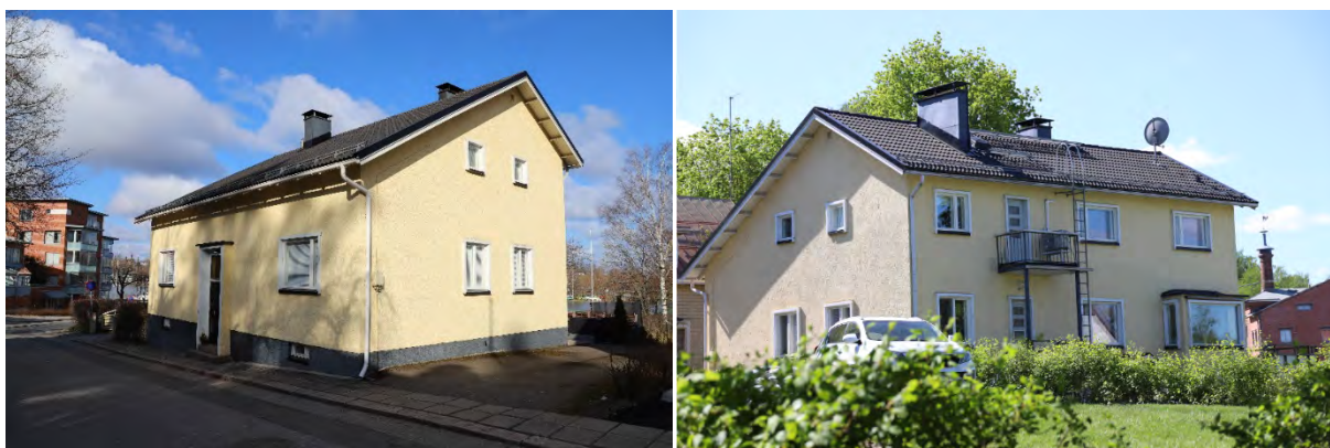
Kuva 14 Neulasepänkatu 4, vasemmanpuoleinen kuva on kuvattu kadulta ja oikeanpuoleinen rannan puolelta.
